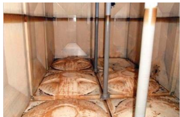
水槽内部 清掃前
