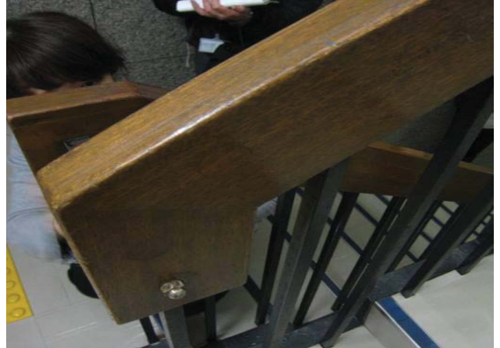
階段手すりターン廻りの手あか
