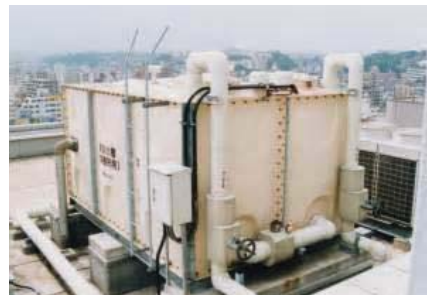
高置水槽:6面点検
