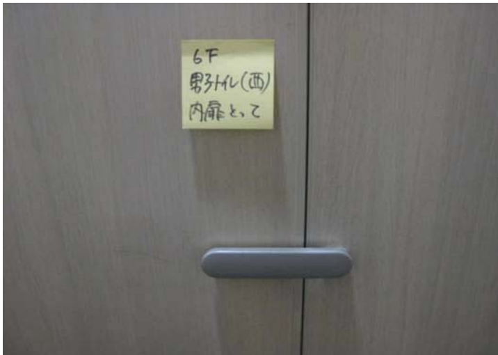
トイレブース内扉取手部分の手あか
